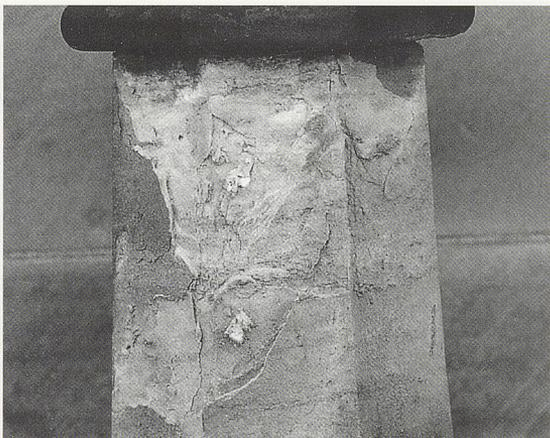
Stellen an Fialen, Dekor und Masswerk konnten mit einem auf den Stein abgestimmten Zementmörtel, dessen Anwendung am Bau vorgeprüft worden war, aufmodelliert werden. Nur der Fuss des Turmhelmes wurde aus statischen Gründen in Epoxydharzmörtel gesichert. Grosse Aufmerksamkeit kam der Wahl des notwendigen Steinersatzes zu. Der Zaberner Sandstein, wie er zusammen mit dem Luzerner Sandstein am Bauwerk verwendet wurde, war nicht mehr erhältlich. Man ersetzte ihn durch
