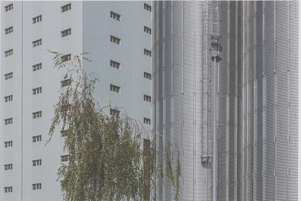
Altes und neues Silo der Rhenus AG: Erhöhung der Lagerkapazitäten um Zehntausende von Tonnen
